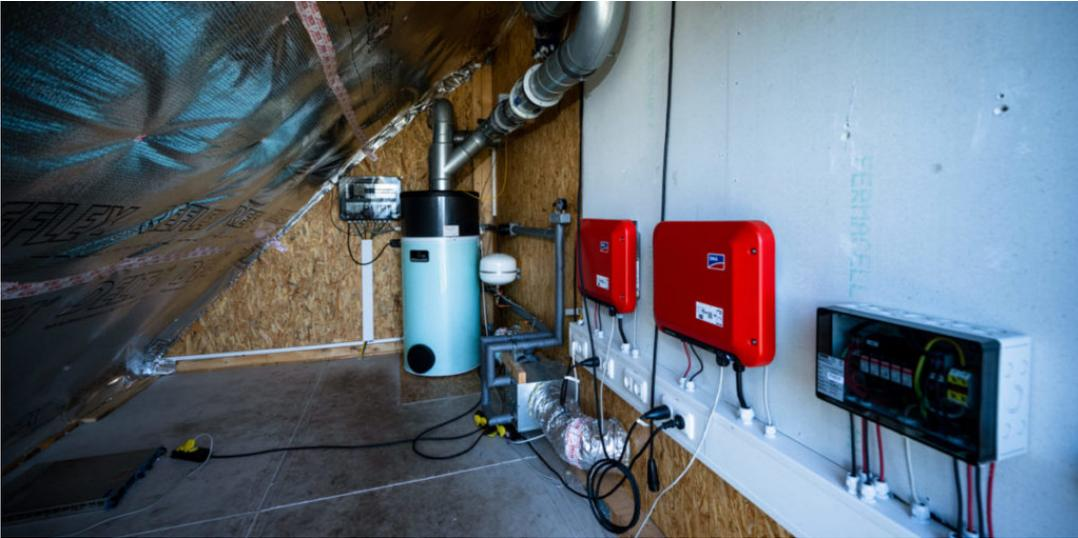
Die angekoppelte Luft-Wärmepumpe, die von der Solaranlage vorgewärmte Luft nutzt.
